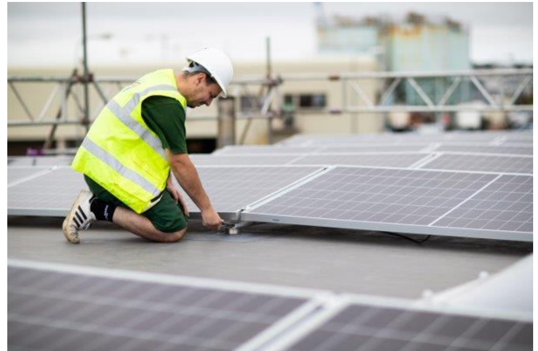
Installation de panneaux solaires chez un client GPL.
