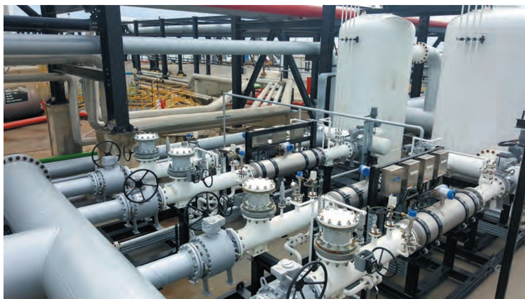
Nouveau débitmètre installé sur un terminal.
